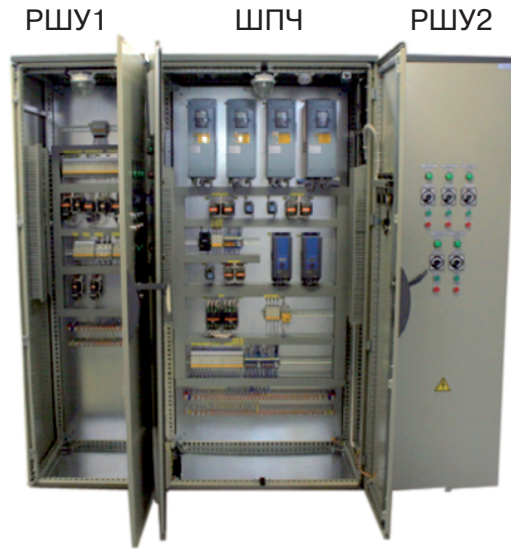
Внешний вид шкафов РШУ1, ШПЧ и РШУ2 щита ЩУ-ЧЭ (пример)
